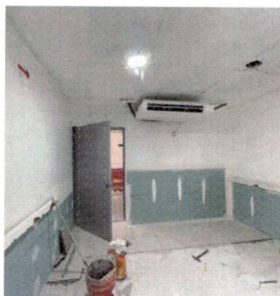
Reparación de muros.
