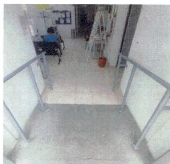
Suministro y colocación de barandal pasamanos.
