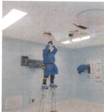
Sustitución de plafón.
