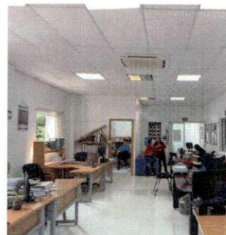
Sustitución de loseta en mal estado.
