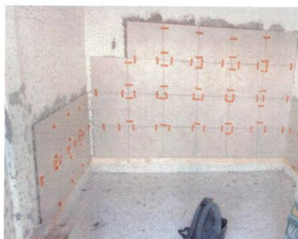
Suministro y colocación de azulejo en muro.
