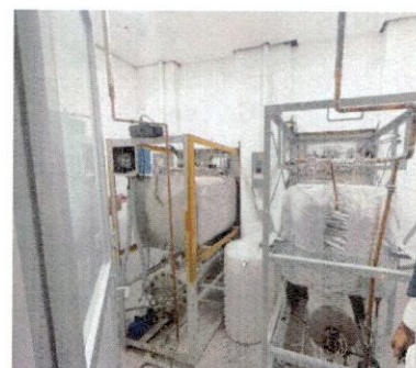
Aplicación de pintura en muros y plafón.
