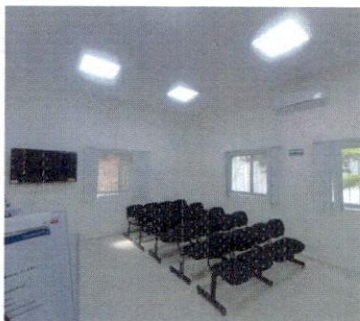
Aplicación de pintura en muros.
